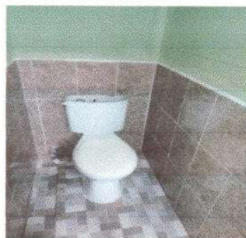
Foto 10: Sustitucion de inodoros
