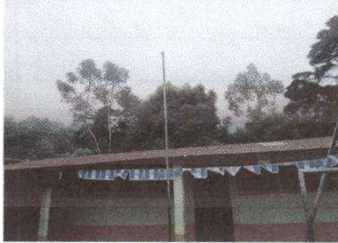
Foto1: Sustitucion de lamina por lamina troquelada
