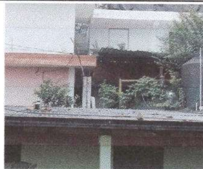
Foto 2: sustitucion de capote de lamina para lamina troquelada.
