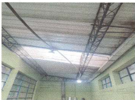
Foto 9: Pintura en muros exteriores e interiores
