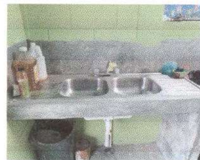
Foto 16: Sustrucion de lavatrastos
