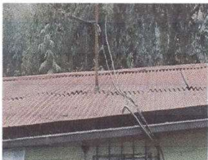
Foto 7: Sustitucion de canal de metal
