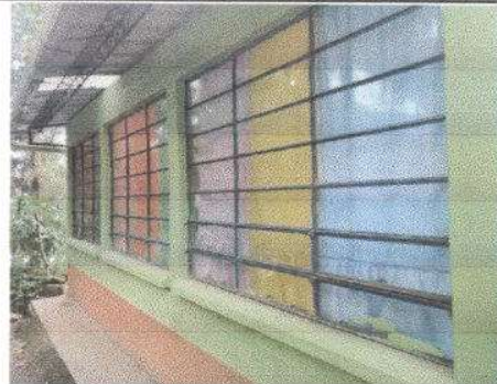
Foto 14: Fabricacion e instalacion de Balcones de Hierro en ventanas
