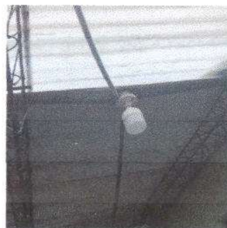
Foto 12: Sustitucion de plafoneras
