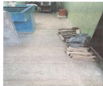
Foto6: Sustitucion de piso de granito.
