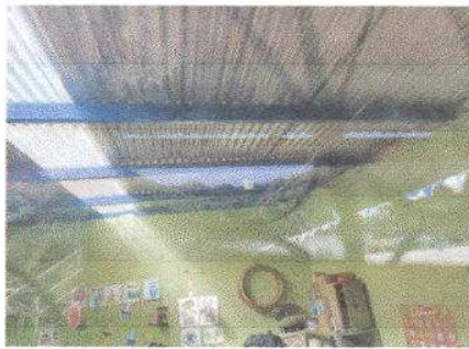
Foto 3: Mantenimiento de estructura de soporte de metal.
