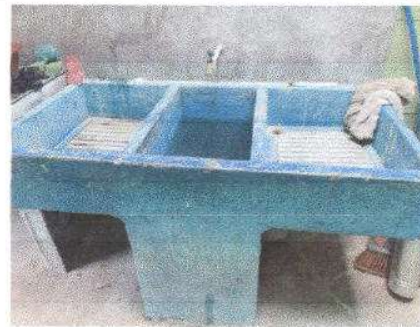
Foto 16: sustitucion de pila de cemento de 2 lavaderos
