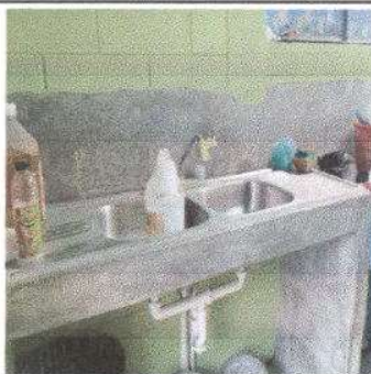
Foto 15: Reparacion de azulejos en mueble de cocina
