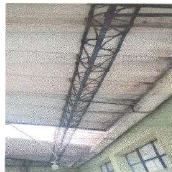
Foto 8: sustitucin de canal de metal de PVC
