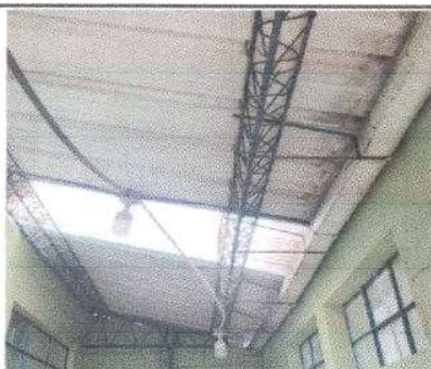
Foto 11: Sustitucion de focos ahorradores
